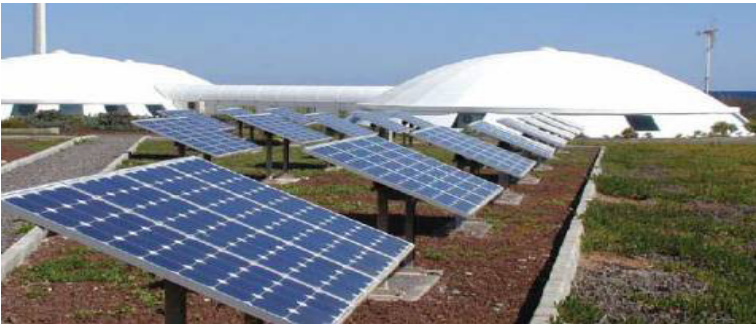
الشكل 16: صورة الألواح الشمسية التي تغذي نظاما مستقلا لتحلية المياه بالتناضح العكسي، يعمل منذ 1998 في جزر الكناري [51]
